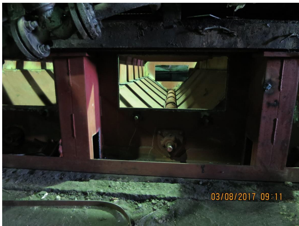
Замена топки котла №4
