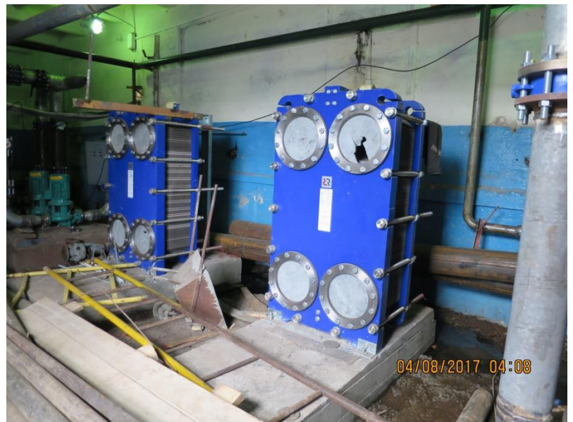
Монтаж насосного и теплообменного оборудования ЦТП-20
