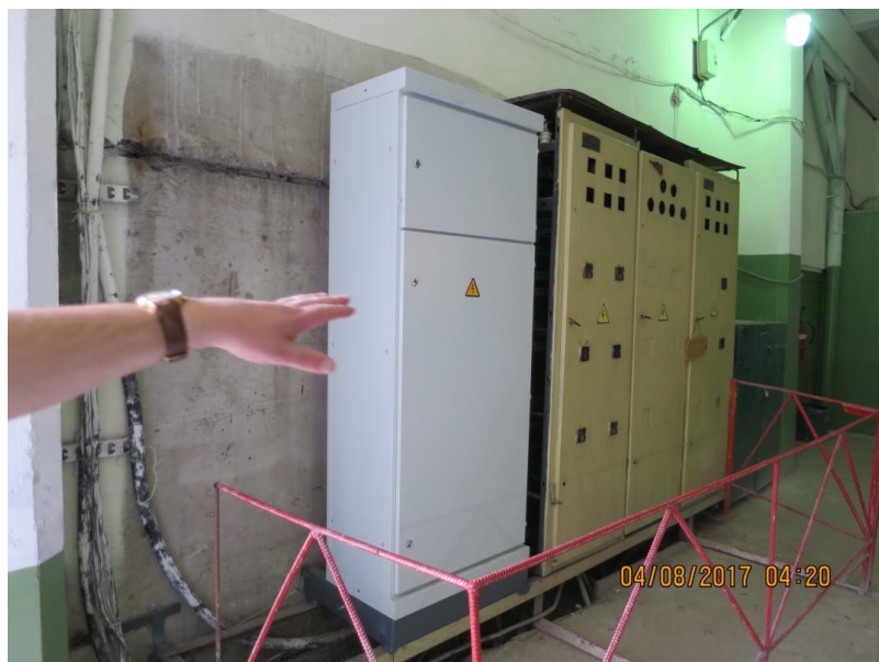
Замена ВРУ ЦТП-29
