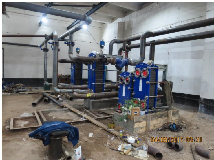
Монтаж теплообменного оборудования ЦТП-18
