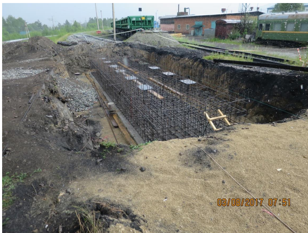
Подготовка фундамента вагонных весов
