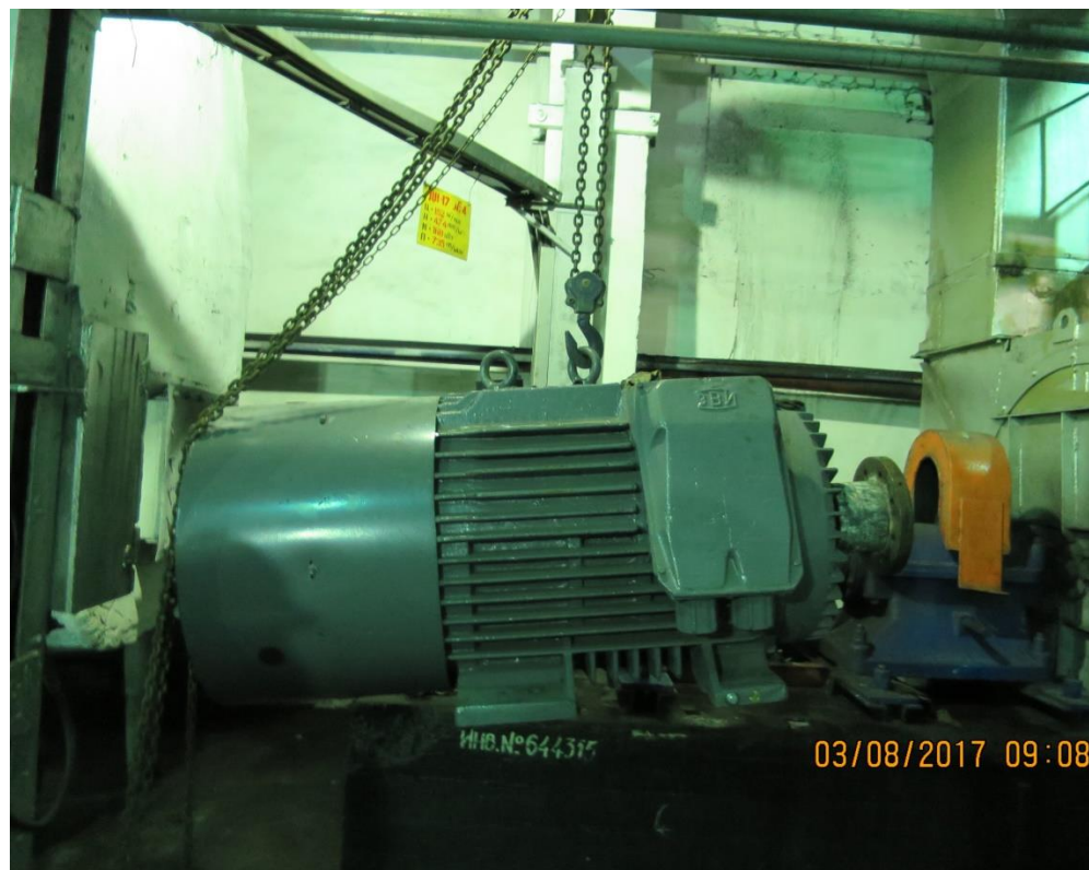
Замена электродвигате ля дымососа котла №4
