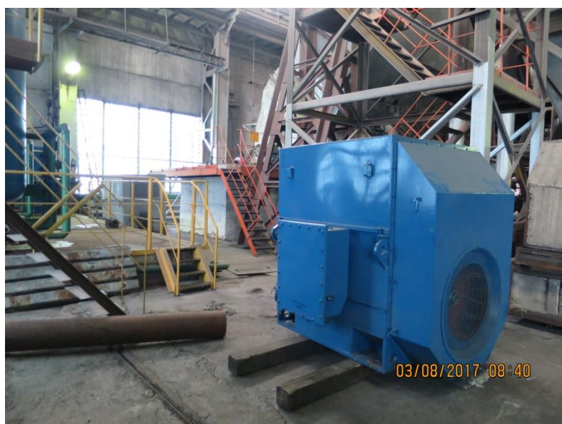
Замена электродвигателя дымососа ДН котла №7
