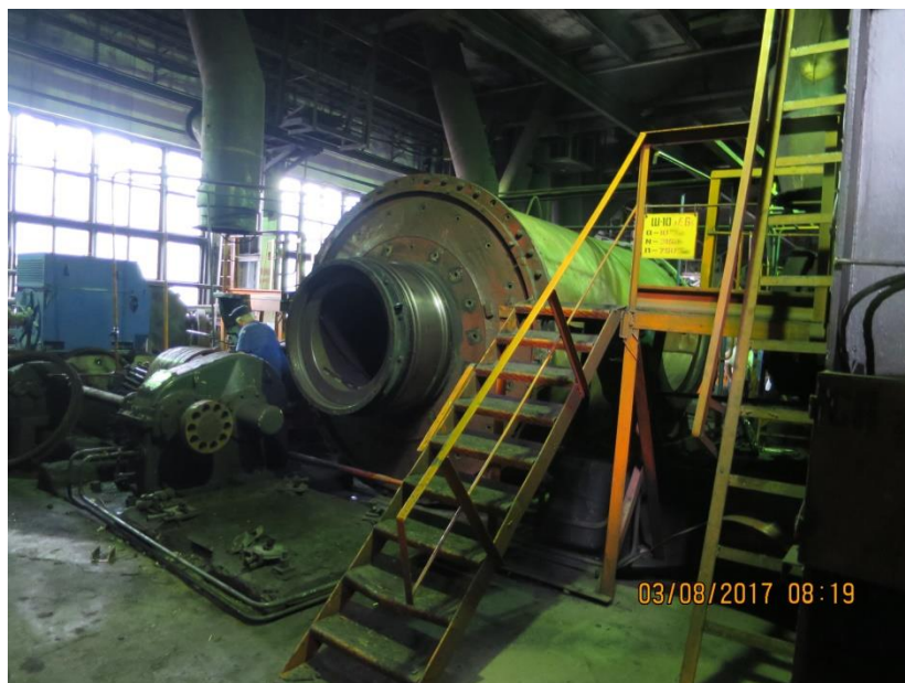
Демонтаж ШБМ котла №7
