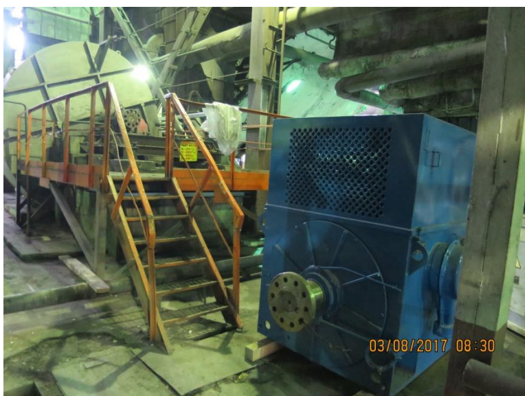
Замена электродвигателя дутьевого вентилятора ВДН котла №6
